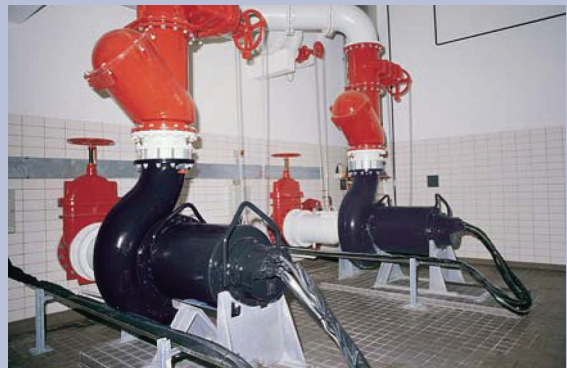
Bombas instaladas horizontalmente con camisa enfriadora.
